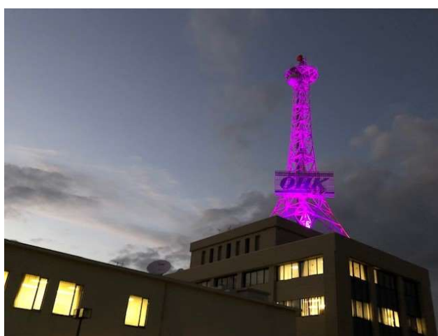
11月12日17:30頃の本社鉄塔ライトアップ光景
